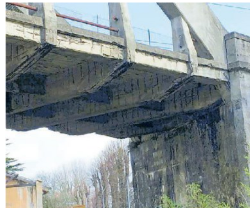
Un dettaglio del ponte segnalato da Casucci
