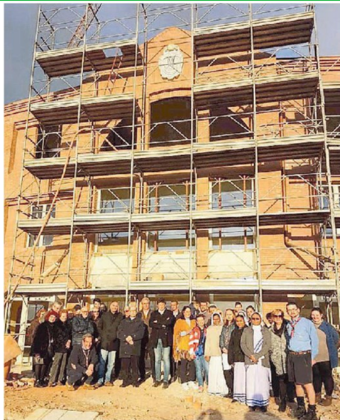
Una visita al cantiere di Orentano
