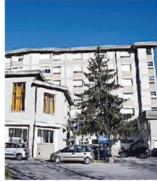
L'ospedale di Pontremoli
