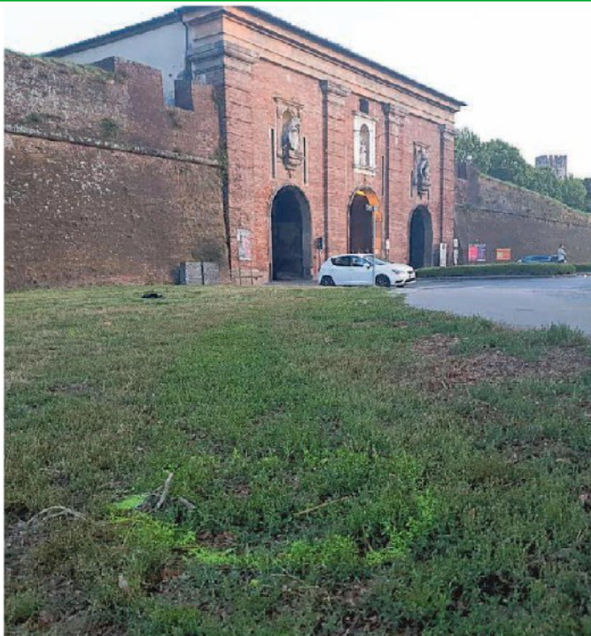
I rilievi eseguiti dalla Polizia municipale davanti a Porta Santa Maria
