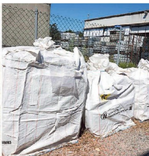
Alcune balle di amianto pronte per lo smaltimento
