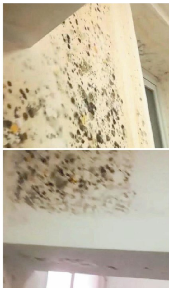
Un corridoio dell'edificio 7 dove sono evidenti le macchie di muffa. In alto e sopra due dettagli delle condizioni delle pareti dei locali ospedalieri
