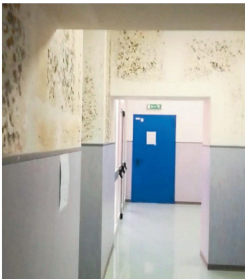
Un corridoio dell'edificio 7 dove sono evidenti le macchie di muffa. In alto e sopra due dettagli delle condizioni delle pareti dei locali ospedalieri
