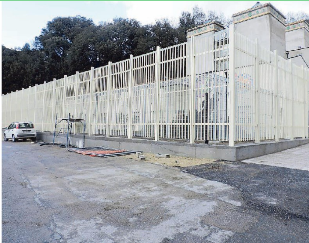
L'esterno della Rems di Volterra
