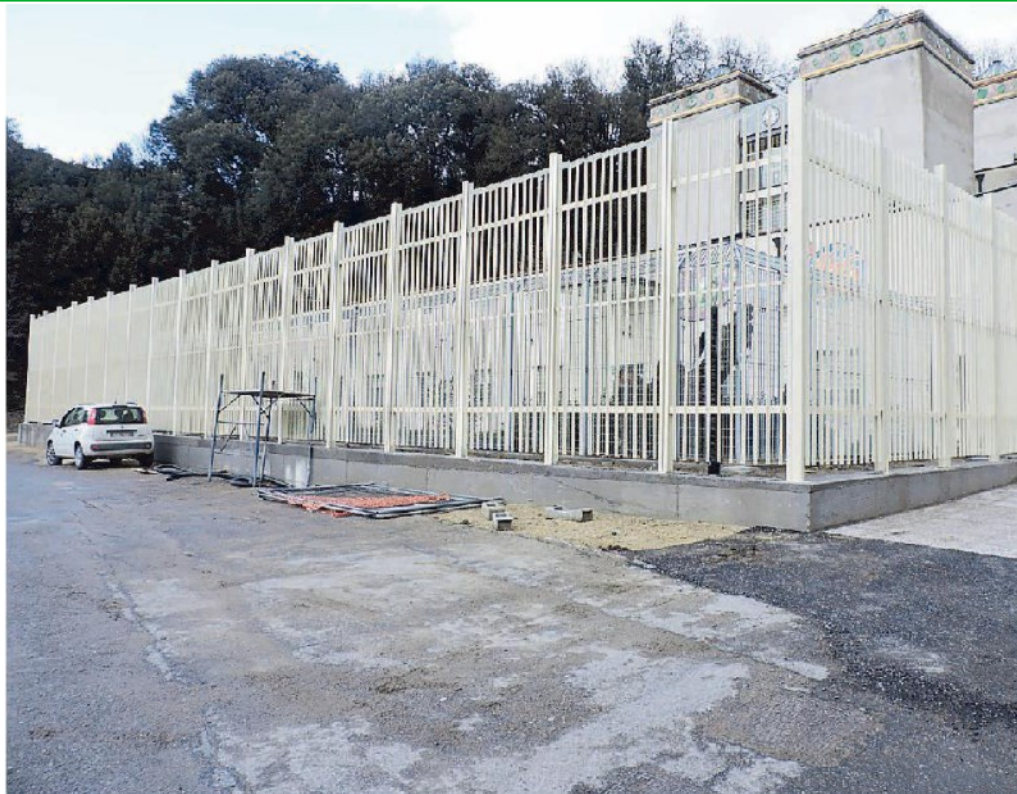
L'esterno della Rems di Volterra
