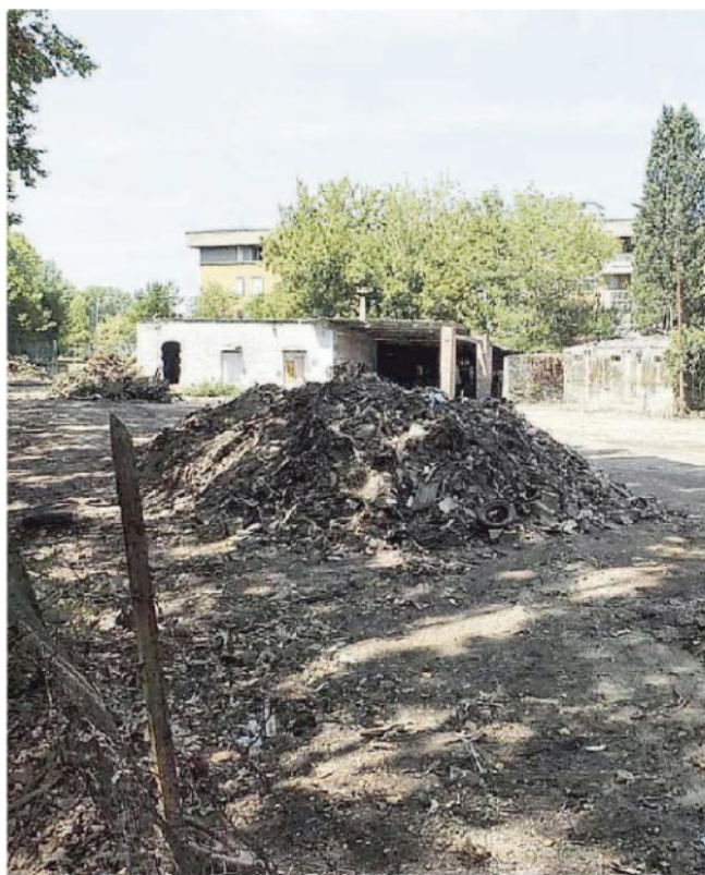
L'area acquistata dalla comunità islamica a Porta a Lucca
