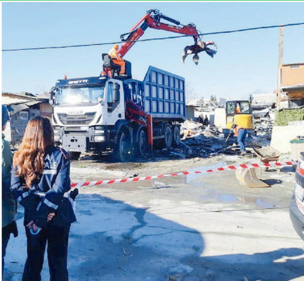
Le ruspe in azione lo scorso 5 settembre nel campo abusivo di Ospedaletto
