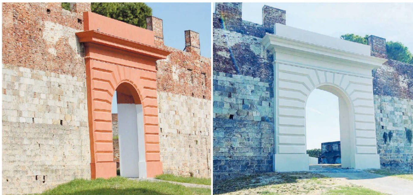
A sinistra la porta come era stata ristrutturata dal Comune in un primo momento; a destra la porta come si presenta oggi dopo l'intervento della Soprintendenza
