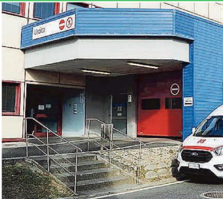
L'ingresso dell'ospedale di Cecina
