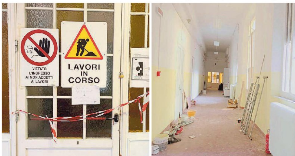
I lavori ancora in corso al 4° padiglione dove doveva trasferirsi un anno fa la Diabetologia (REPETTI)
