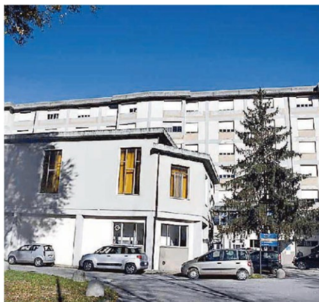
L'ospedale di Pontremoli
