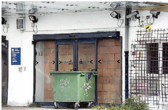
Uno degli ingressi murati del vecchio ospedale
