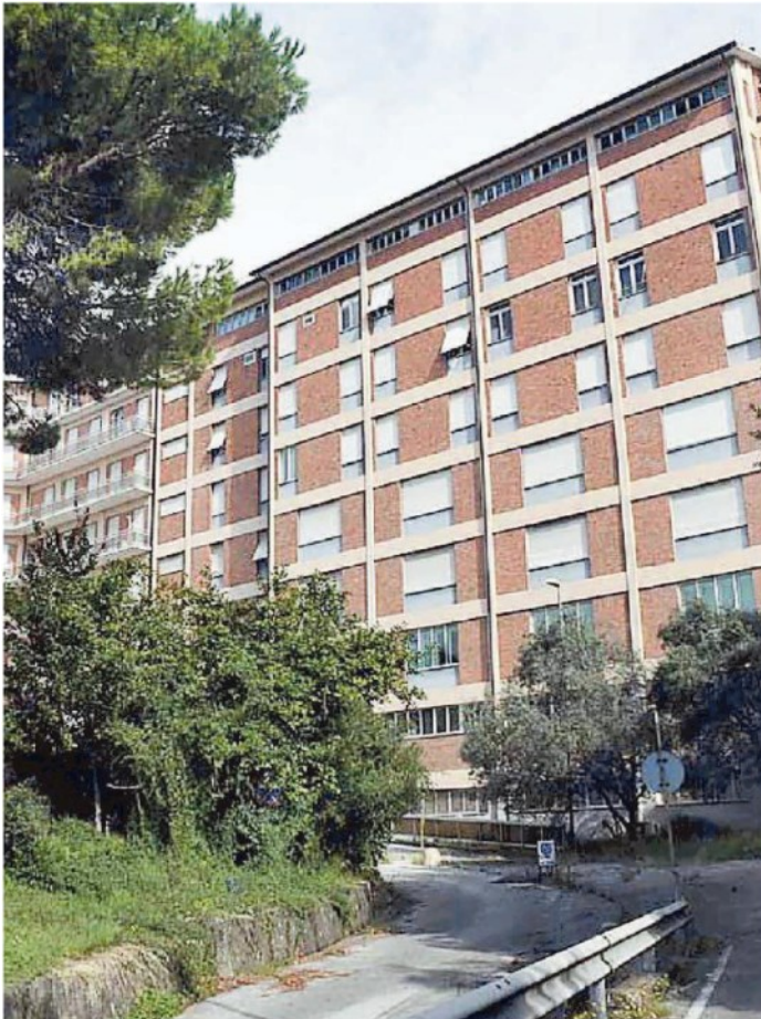
Un dettaglio dell'ospedale dismesso
