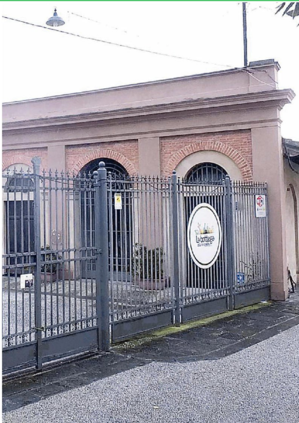
L'ingresso della Stazione Leopolda
