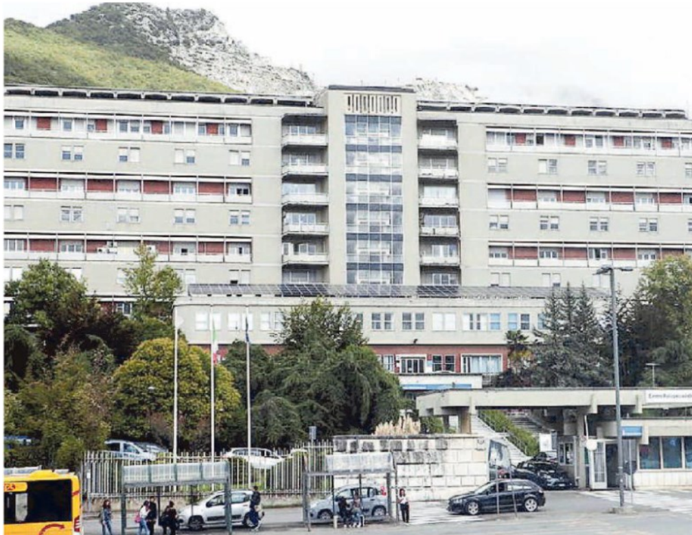
Il monoblocco: l'unità operativa di Dermatologia si trova in questa struttura
