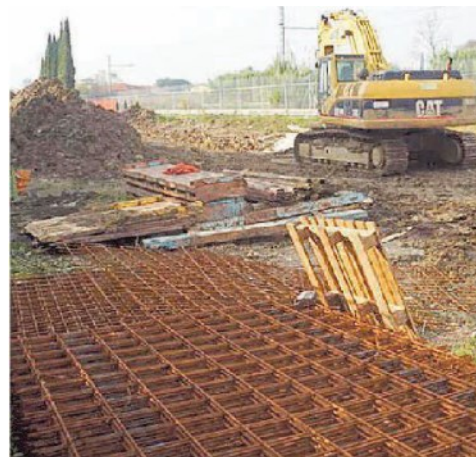
Uno dei cantieri ai Passi
