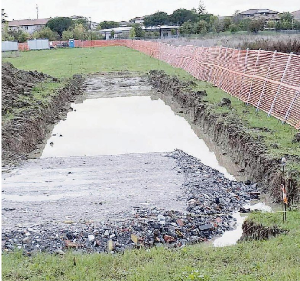
I lavori in corso nell'area dove deve sorgere la nuova cittadella universitaria del Sant'Anna (FOTO MUZZI)
