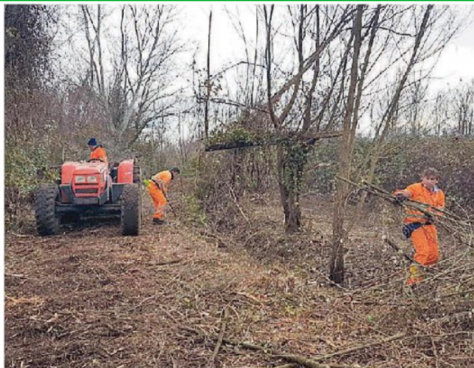
Lavori di bonifica al parco urbano di Cisanello
