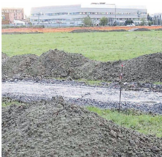
Lo scavo per il nuovo campo della Scuola Sant'Anna in zona Praticelli
