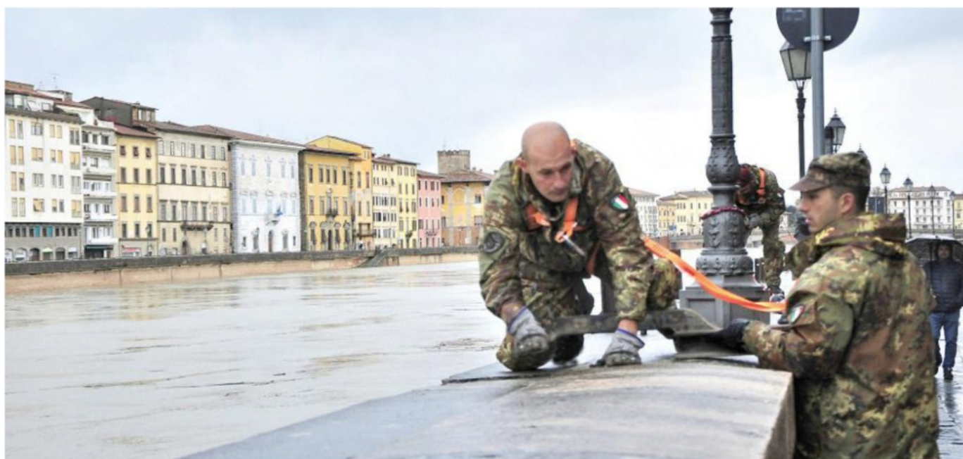
I paracadutisti della Folgore al lavoro sul Lungarno di Pisa. I militari hanno partecipato alle operazioni di contenimento della piena del fiume con interventi sulle spallette, issando le paratie
