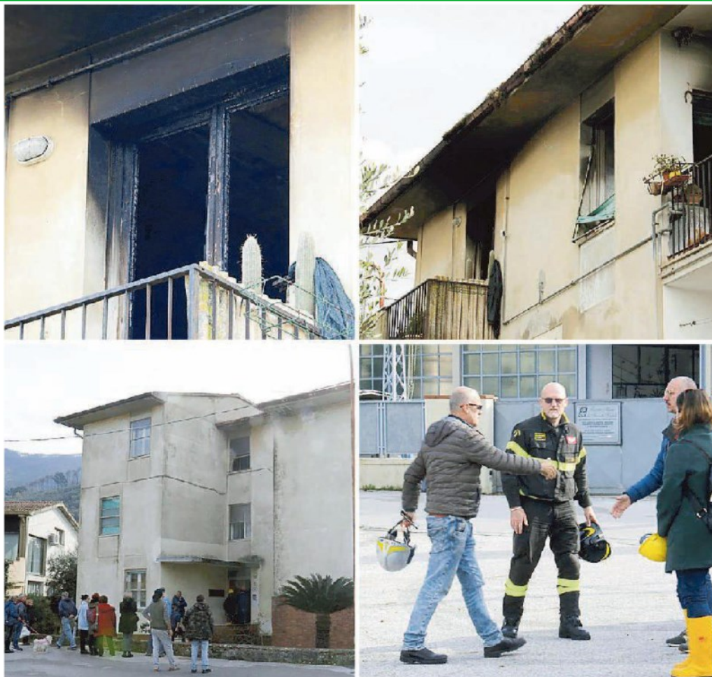
In alto due dettagli dei danni provocati dall'incendio agli infissi e al tetto dell'alloggio distrutto dalle fiamme; sopra il palazzo Apes di via Buozzi e a destra l'arrivo dei tecnici per il sopralluogo (FOTO RENZULLO)
