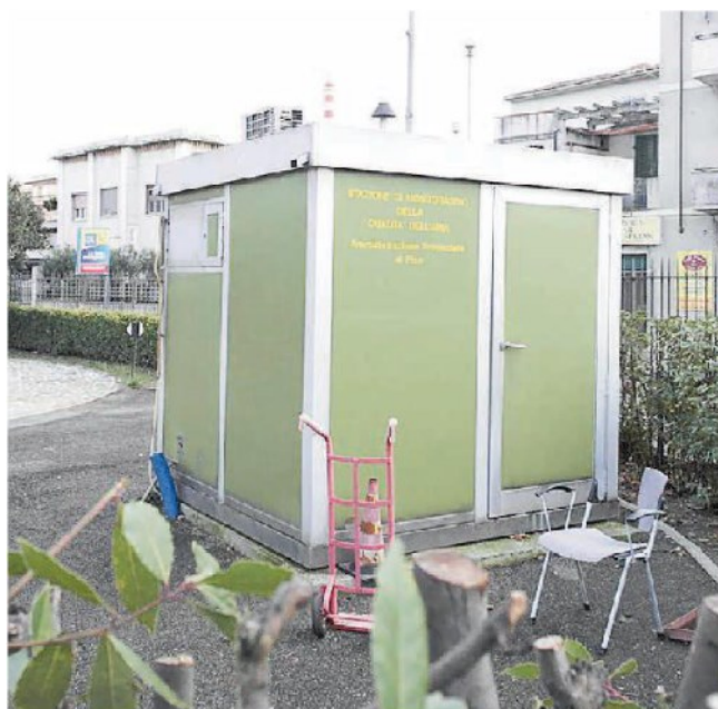
Una centralina per il controllo dell'aria
