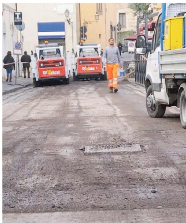
L'asfaltatura di una strada
