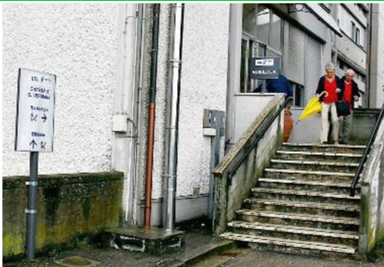
Indetta la gara per la realizzazione dei lavori nell'ospedale di Santa Verdiana
