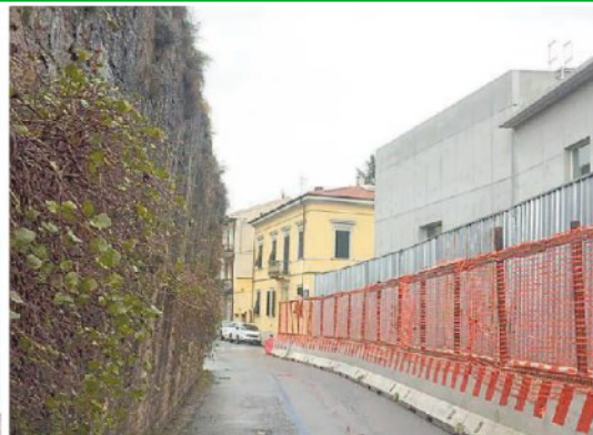
Il cantiere in via Pisano
