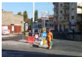
Lavori stradali da lunedì 10 febbraio. Attenzione a sosta e circolazione
