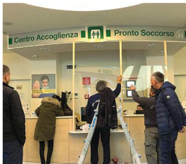
In alto l'avviso e il gel disinfettante all'ingresso del pronto soccorso. Sopra le barriere all'accettazione di Careggi
