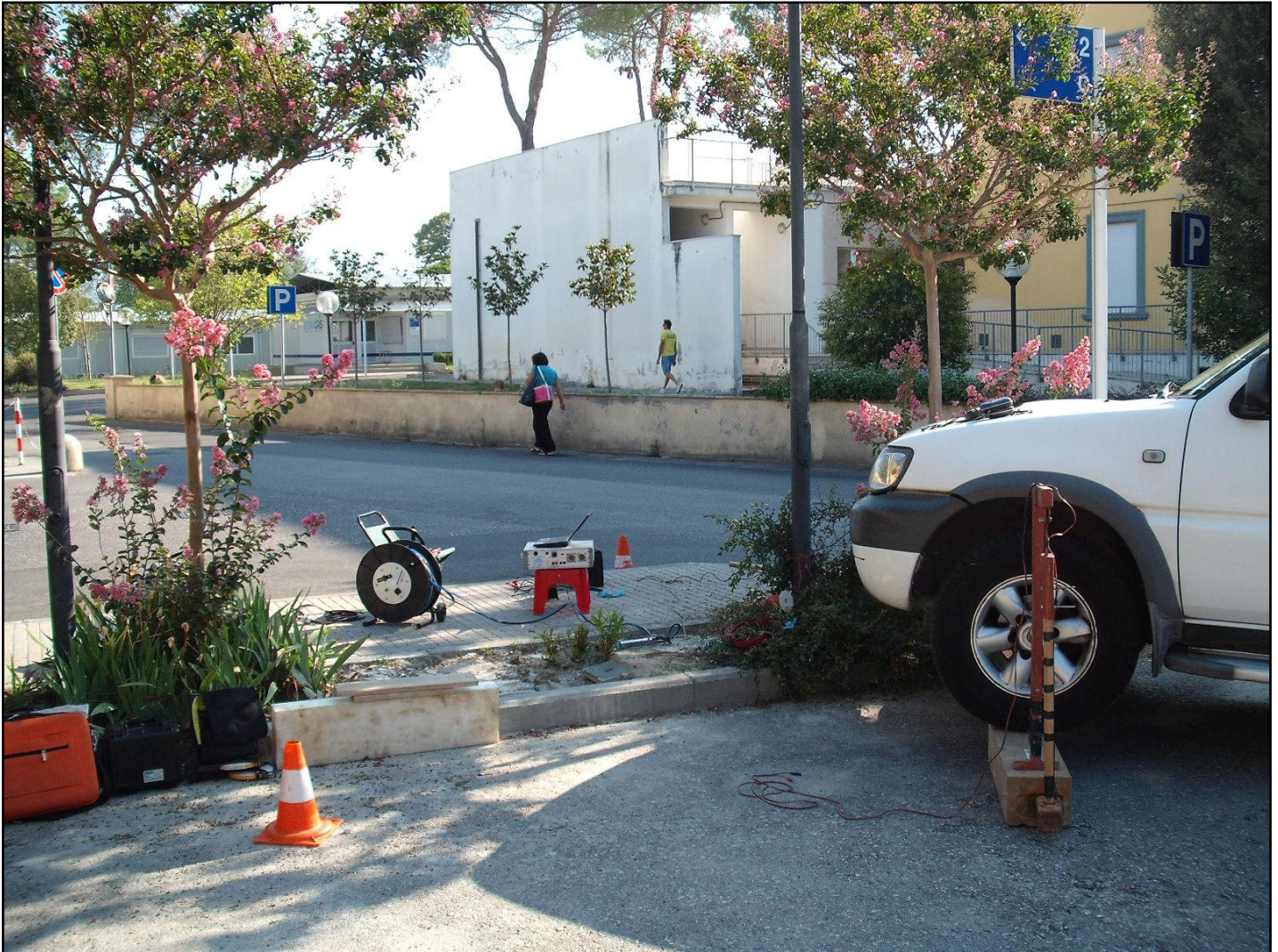
Indagine Down Hole – DH_S2 - Documentazione fotografica.
